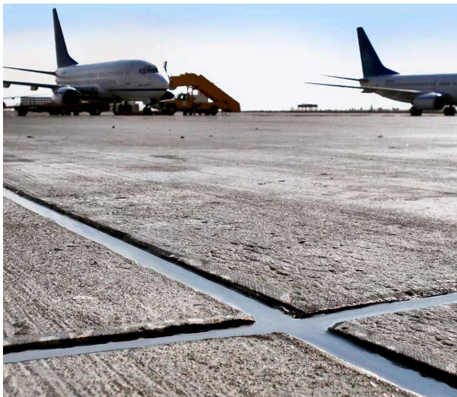
Toepassing van voegmassa op een vliegveld.
