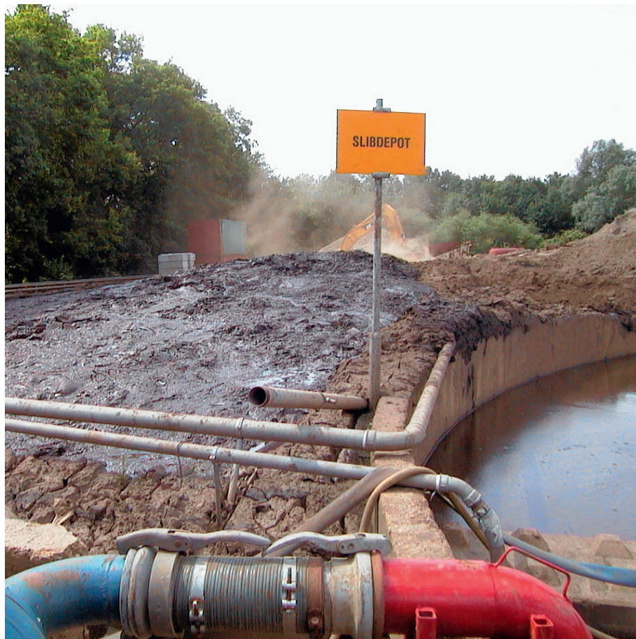
Bodembescherming onder een slibdepot.
