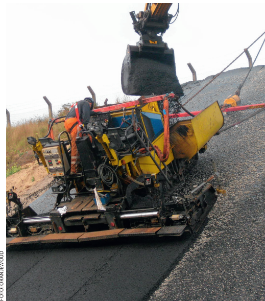
Taludafwerking in asfalt.
